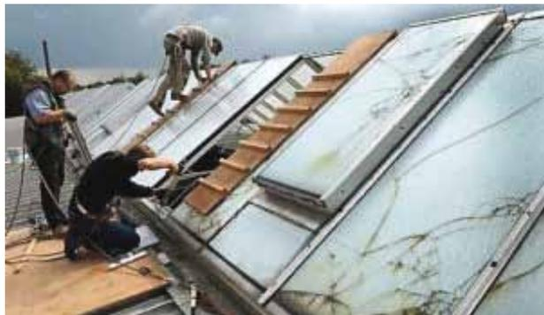
Risse auf und mussten komplett ausgetauscht werden. Da das Risiko bestand, dass jemand durch herunterstürzende Splitter verletzt wird, wurde die Halle aus Sicherheitsgründen sofort gesperrt.
